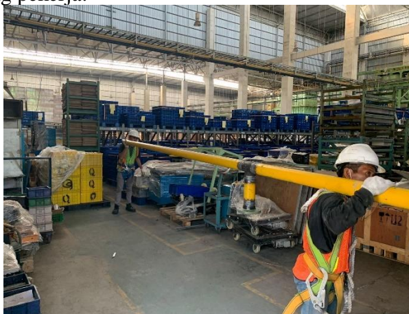
Gambar 1. Proses Pemindahan Pipa
