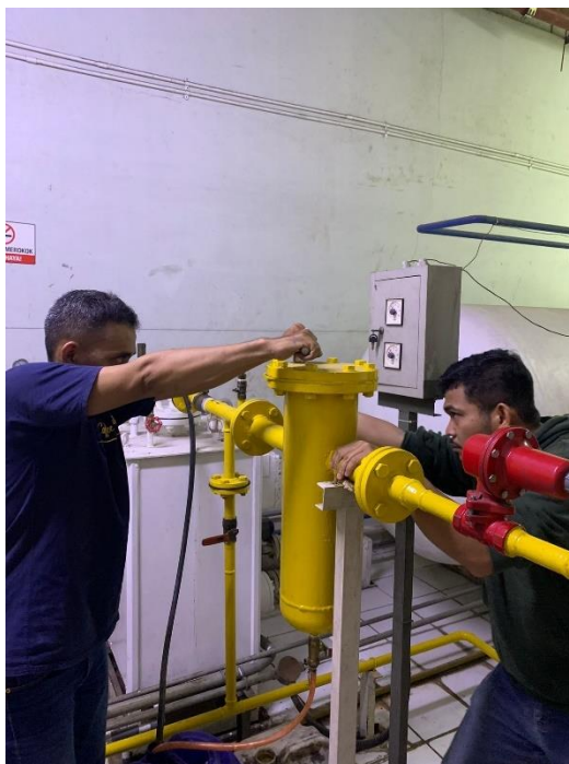
Gambar 3. Proses Pemasangan Pipa
