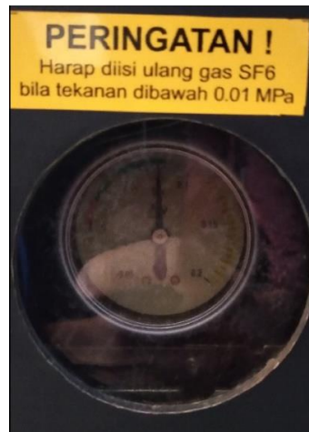
Gambar 3. Indikator Gas SF 6 pada kubikel
