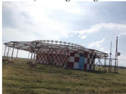
Gambar 4. 3 Kondisi tanah di gedung DVOR Sumber : Dokumentasi Penulis
