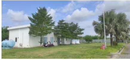
Gambar 4.4 Kondisi tanah di MPH (Main Power House)
