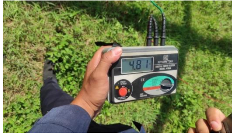
Gambar 4. 2 Hasil pengukuran di gedung DVOR Sumber : Dokumentasi Penulis
