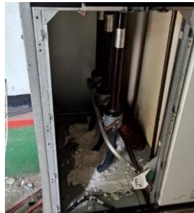
Gambar 7. Penggantian kabel indor
