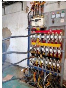
Gambar 6. Pemeliharaan PHB TR Sumber : Dokumentasi pribadi
