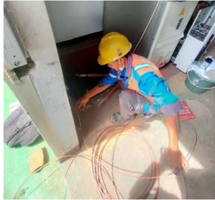
Gambar 8. Penormalan grounding Sumber : Dokumentasi pribadi
