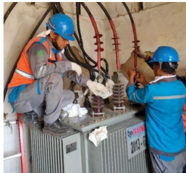
Gambar 5. Pemeliharaan trafo Sumber : Dokumentasi pribadi
